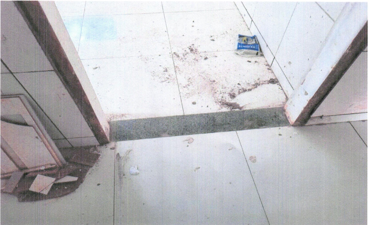
FOTO 16 - SOLEIRA EM GRANITO, LARGURA 15 CM, ESPESSURA 2,0 CM. AF_09/2020
