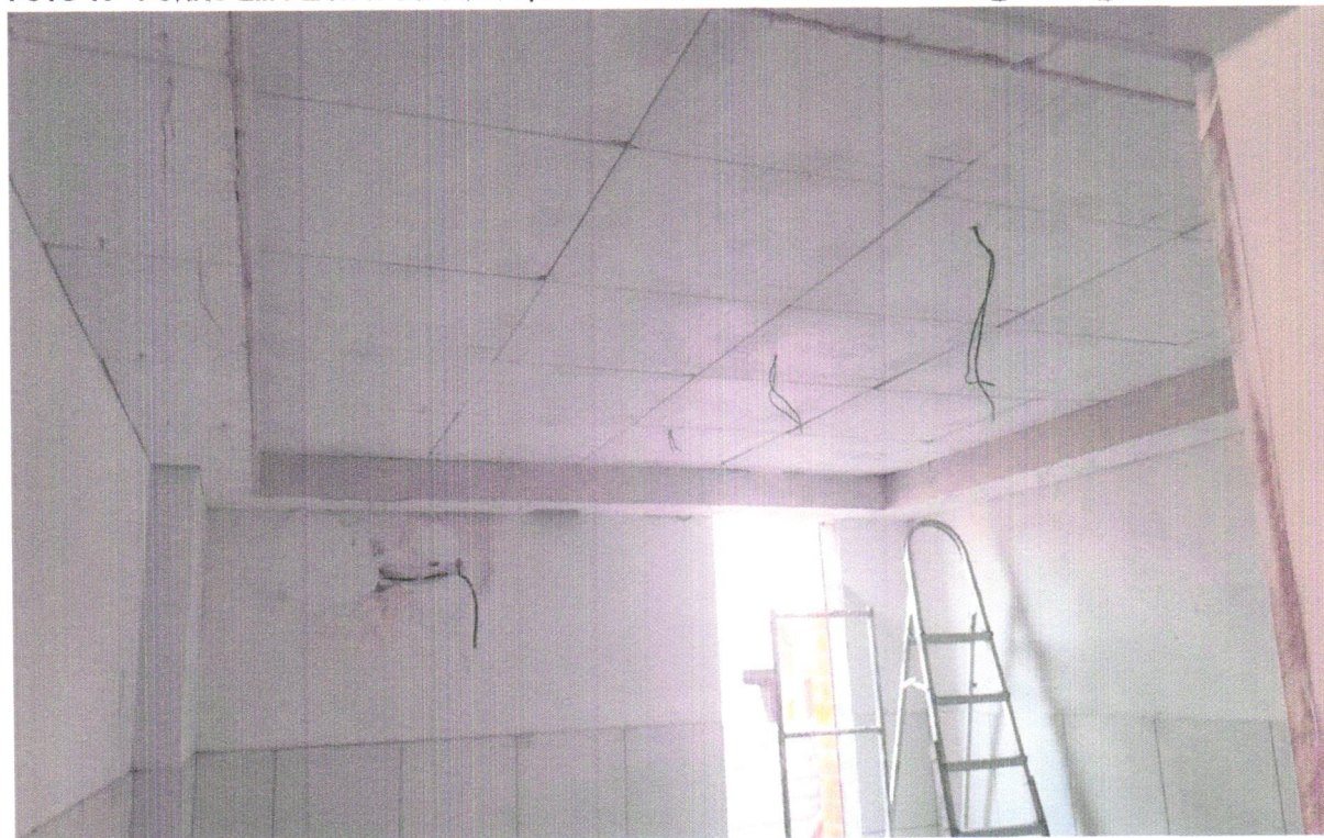
FOTO 18 - FORRO EM PLACAS DE GESSO, PARA AMBIENTES COMERCIAIS. AF_05/2017_P
