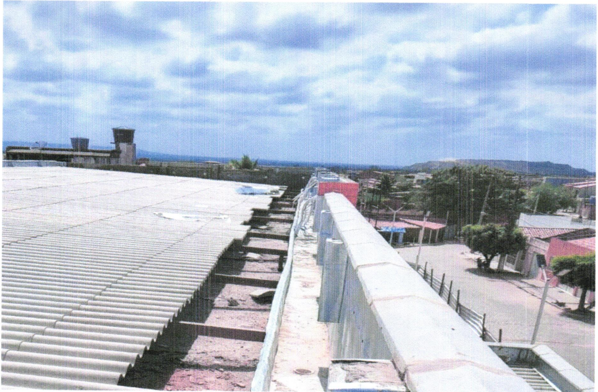
FOTO 32 - RUFO EM CHAPA DE AÇO GALVANIZADO NÚMERO 24, CORTE DE 25 CM, INCLUSO TRANSPORTE VERTICAL. AF_07/2019
