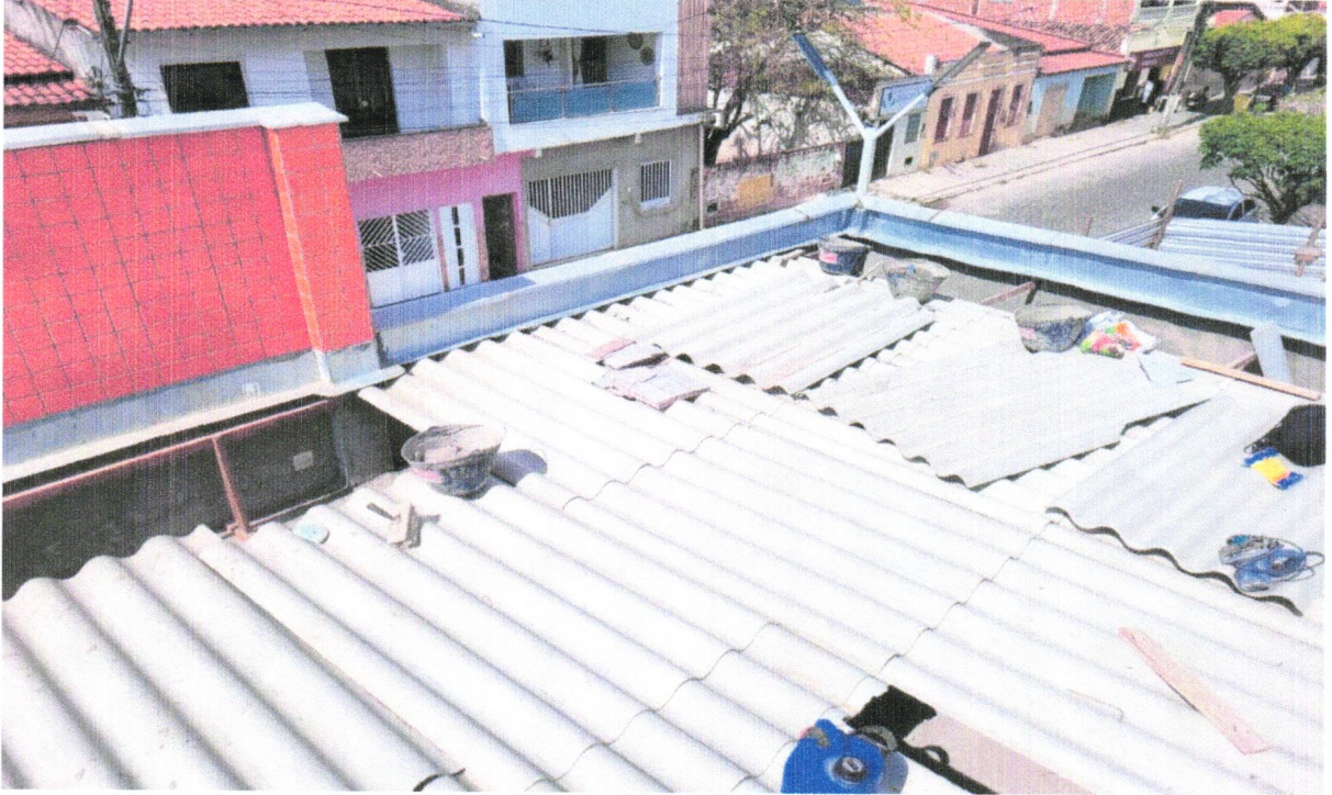
FOTO 34 - CALHA EM CHAPA DE AÇO GALVANIZADO NÚMERO 24, DESENVOLVIMENTO DE 50 CM, INCLUSO TRANSPORTE VERTICAL. AF_07/2019
