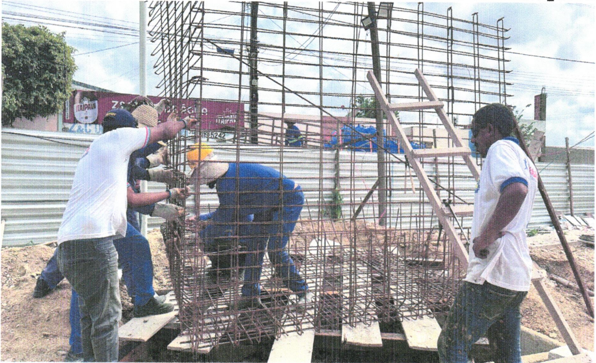
FOTO 04 - ARMAÇÃO DE PILAR OU VIGA DE UMA ESTRUTURA CONVENCIONAL DE CONCRETO ARMADO EM UMA EDIFICAÇÃO TÉRREA OU SOBRADO UTILIZANDO AÇO CA-50 DE 8,0 MM - MONTAGEM. AF_12/2015
