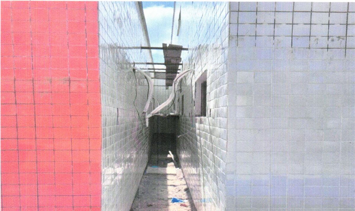
FOTO 14 - PASTILHA CERÂMICA ESMALTADA, 5 X 5 CM, MARCA ATLAS, SÉRIE METALO, COR MÁRMORE - SG8408, APLICADA COM ARGAMASSA INDUSTRIALIZADA AC-II, REJUNTADA, EXCLUSIVE EMBOÇO (OU SIMILAR)
