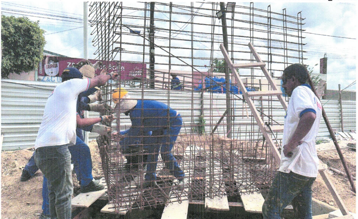
FOTO 04 - ARMAÇÃO DE PILAR OU VIGA DE UMA ESTRUTURA CONVENCIONAL DE CONCRETO ARMADO EM UMA EDIFICAÇÃO TÉRREA OU SOBRADO UTILIZANDO AÇO CA-50 DE 8,0 MM - MONTAGEM. AF_12/2015
