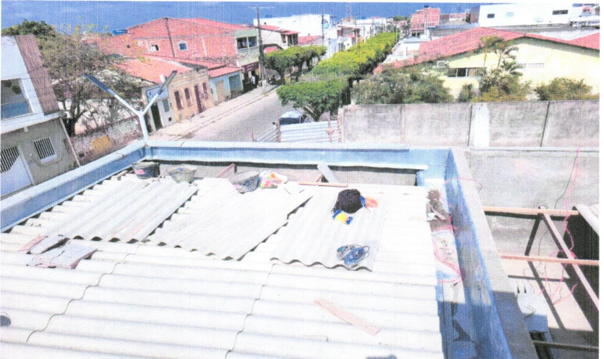
FOTO 34 - CALHA EM CHAPA DE AÇO GALVANIZADO NÚMERO 24, DESENVOLVIMENTO DE 50 CM, INCLUSO TRANSPORTE VERTICAL. AF_07/2019
