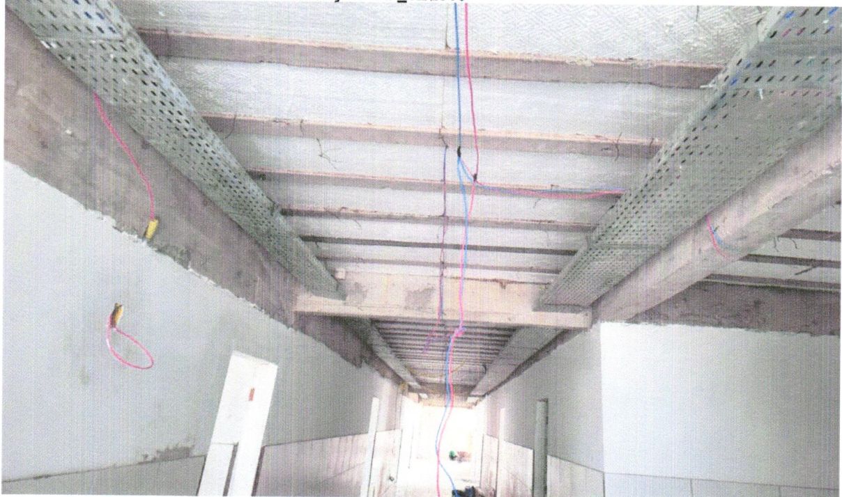
FOTO 40 - CABO DE COBRE FLEXÍVEL ISOLADO, 2,5 MM 2 , ANTI-CHAMA 450/750 V, PARA CIRCUITOS TERMINAIS - FORNECIMENTO E INSTALAÇÃO. AF_12/2015
