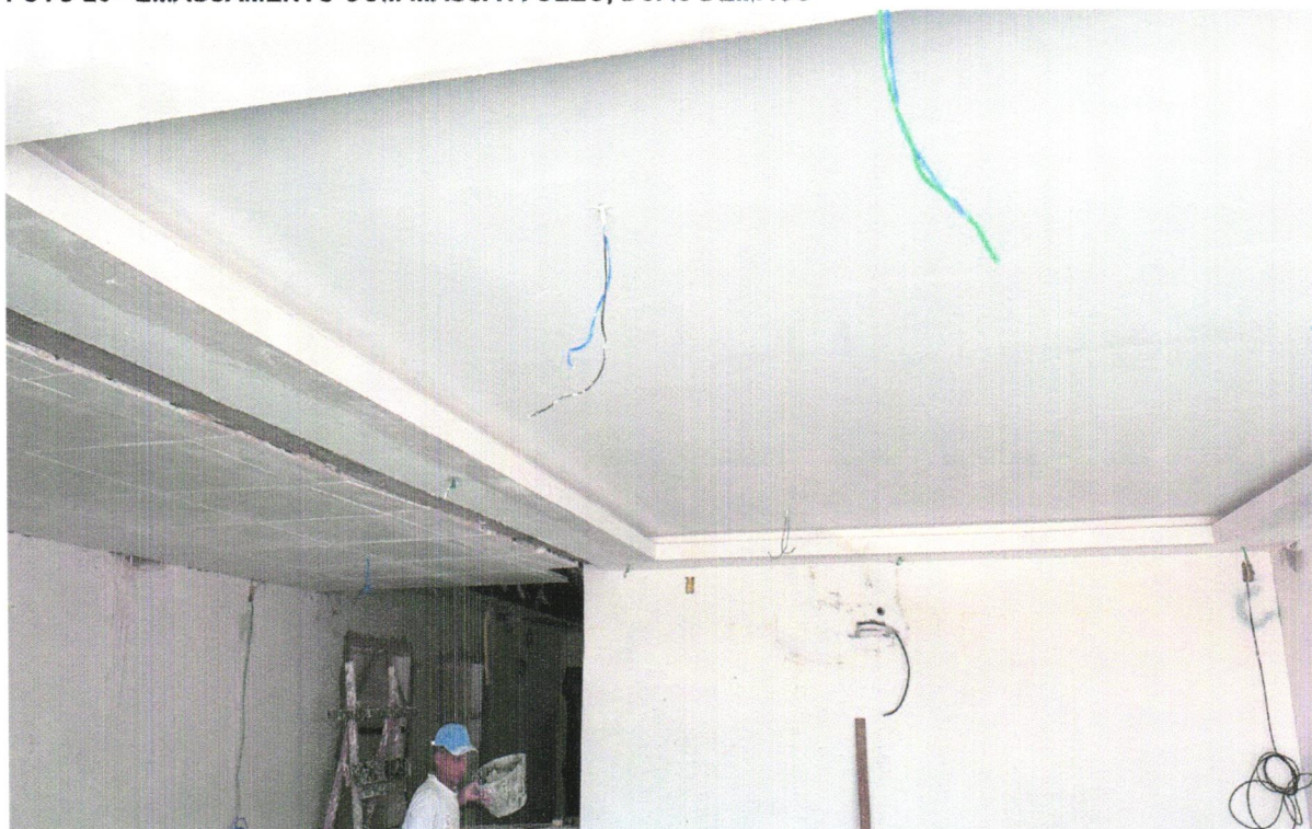
FOTO 20 - EMASSAMENTO COM MASSA A OLEO, DUAS DEMAOS
